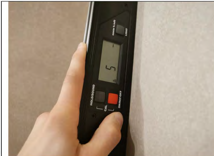
Фото №13. Измерение уровня стен в ванной комнате.
