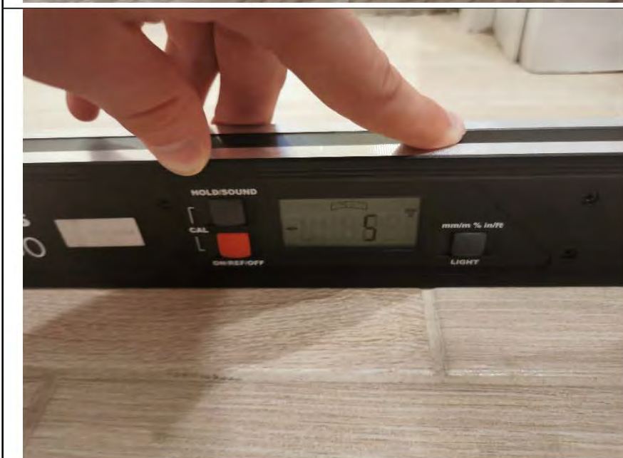
Фото №24. Измерение уровня пола в санузле.
