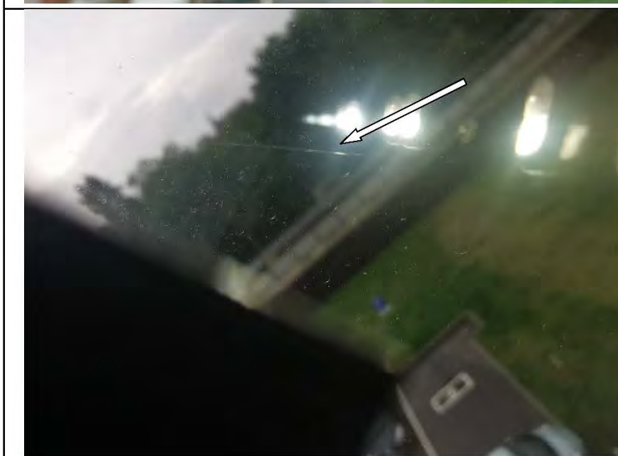
Фото №36. Царапины на стеклопакете металлического оконного блока в спальне.
