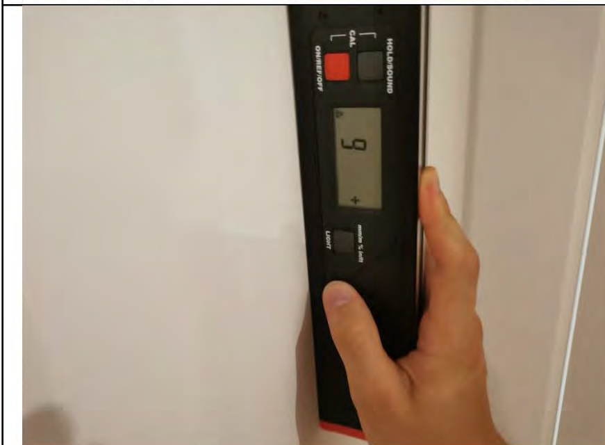
Фото №8. Измерение уровня стен в спальне.
