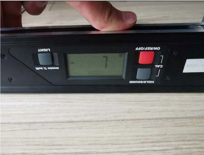
Фото №20. Измерение уровня пола в кухне.
