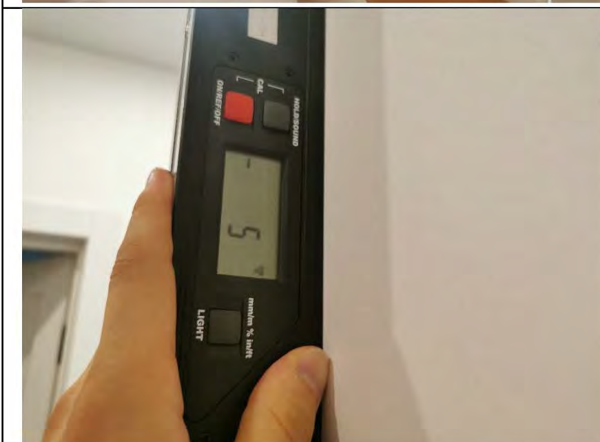
Фото №9. Измерение уровня стен в коридоре.
