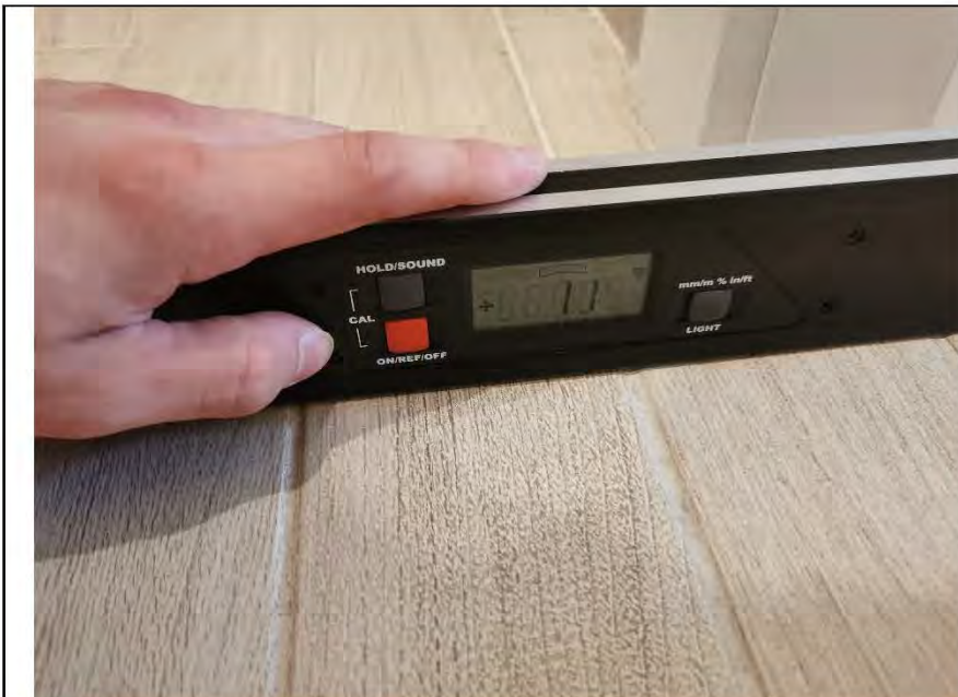
Фото №25. Измерение уровня пола в ванной комнате.
